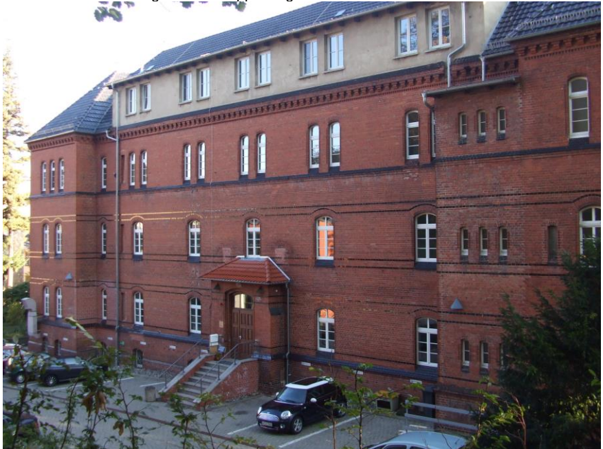
AFI LSA Standort Blankenburg (Hauptgebäude)
