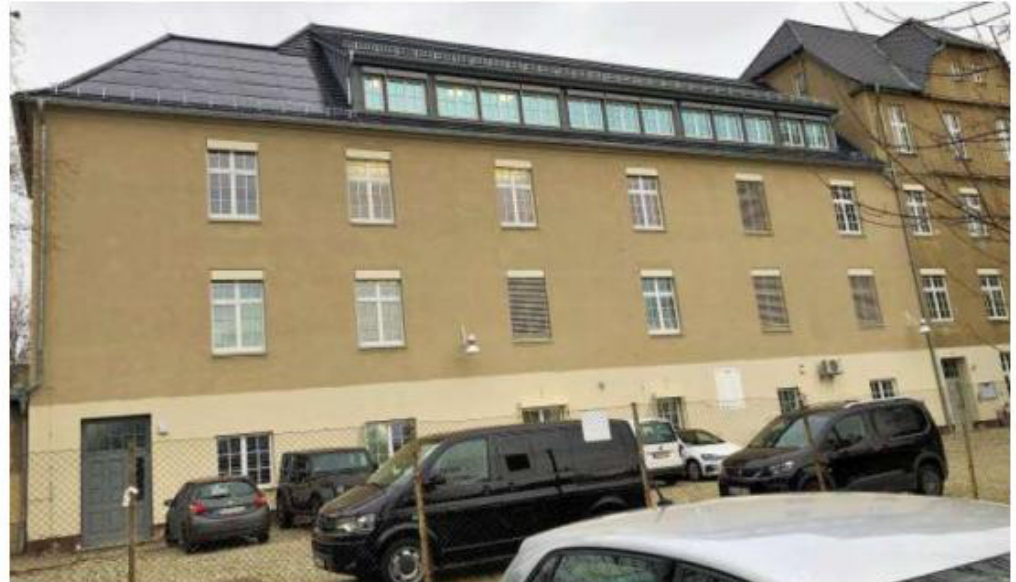
Seinerzeit im Rahmen eines EU-Förderprogramms in der damaligen Studienstadt Quedlinburg entstanden: die Photovoltaik-Anlage auf dem Dach des Verwaltungsgebäudes Halberstädter Straße 45.
