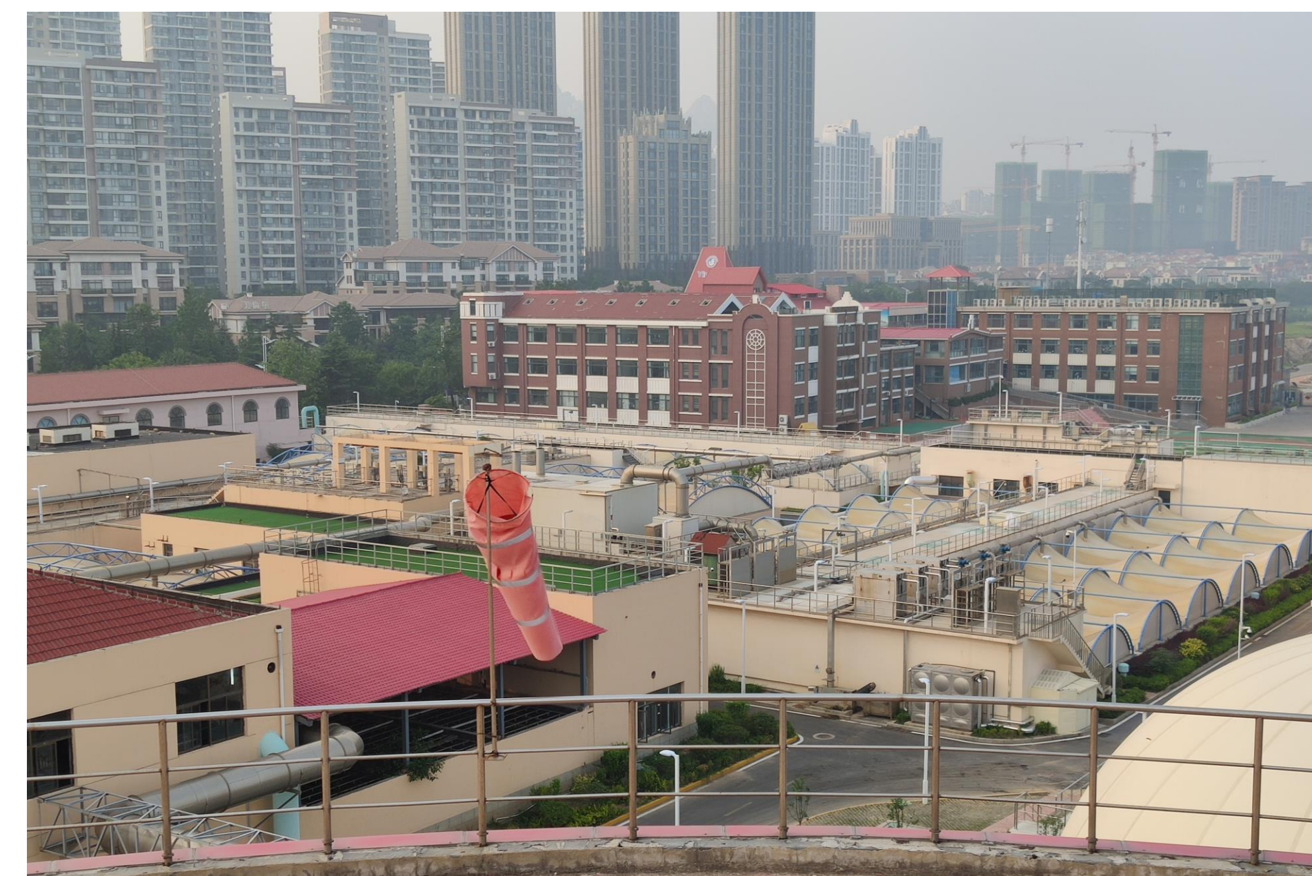
Bild 2: Biologische Behandlungsstufe inkl. Biologischer Aerated Filter (BAF) und denitrifizierender Biofilter einer chinesischen kommunalen Kläranlage (Modellkläranlage) (Bildnachweis: BHU Umwelttechnik GmbH)
