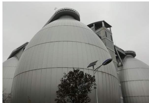
Faultürme einer chinesischen kommunalen Kläranlage.
