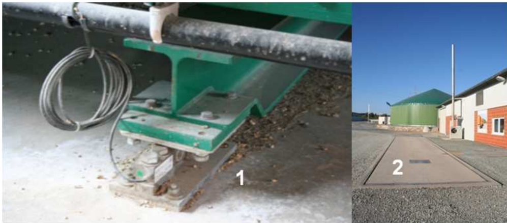
Abb. 3.40: Wägevorrichtungen auf Biogasanlagen (1 = Wägezelle unter einem Feststoffdosierer, 2 = LKW-Fahrzeugwaage) (Bildquellen: Autor)
