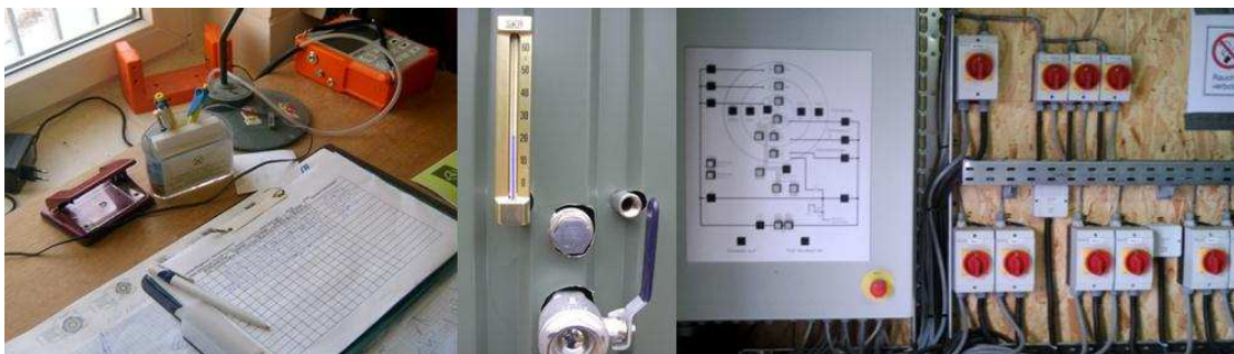
Abb. 9.1: Händisch geführtes Betriebs- und Stoffstromtagebuch (links), Thermometer zum Ablesen der Temperatur in einem Fermenter (Mitte), Bedienfeld und Vorortbedienung einer größeren Biogasanlage (rechts) (Bildquellen: Autor)
