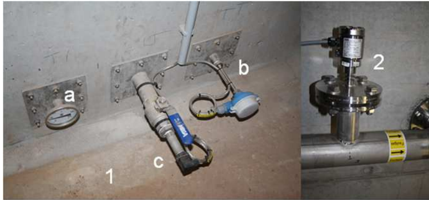
Abb. 3.14: Temperatur- und Druckmessgeräte in der Anaerobtechnik: 1 = Biogasfermenter (1a = Analogthermometer, 1b = Digitalthermometer, 1c = Druckmessgerät als Füllstandsmessung) (Fa. Endress+Hauser), 2 = Druckmessgerät in einer Biogasleitung (Fa. ABB) (Bildquelle: Autor)
