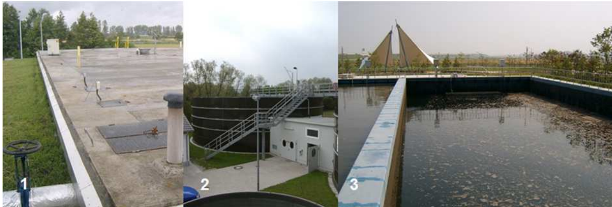
Abb. 5.7: Verschiedene Typen von Reaktoren: Rechteckbecken mit fester Decke in oberirdischer Bauweise und Erdanschüttung (1), oberirdisches Rundbecken aus emaillierten Stahl (2), unterirdisches, offenes Rechteckbecken aus Ortbeton (3) (Bildquellen: Autor)
