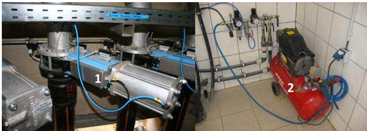
Abb. 4.3: Pneumatikschieber mit Endlagenüberwachung und Spülanschlüssen (1), Druckluftversorgung (2) (Bildquellen: Autor)
