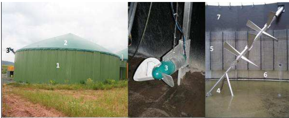
Abb. 8.8: Fermenter mit Dämmung und Verkleidung aus Trapezprofilen (1), Tragluftdach mit integrierter Gasspeicherfolie (2), Tauchmotorrührwerk (3), Schrägflügelrührwerk (4), Flächige innenliegende Heizung (5), Spannbetonfertigteile (6), Schutzbeschichtung gegen H 2 S-Korrosion (7) (Bildquellen: Autor)
