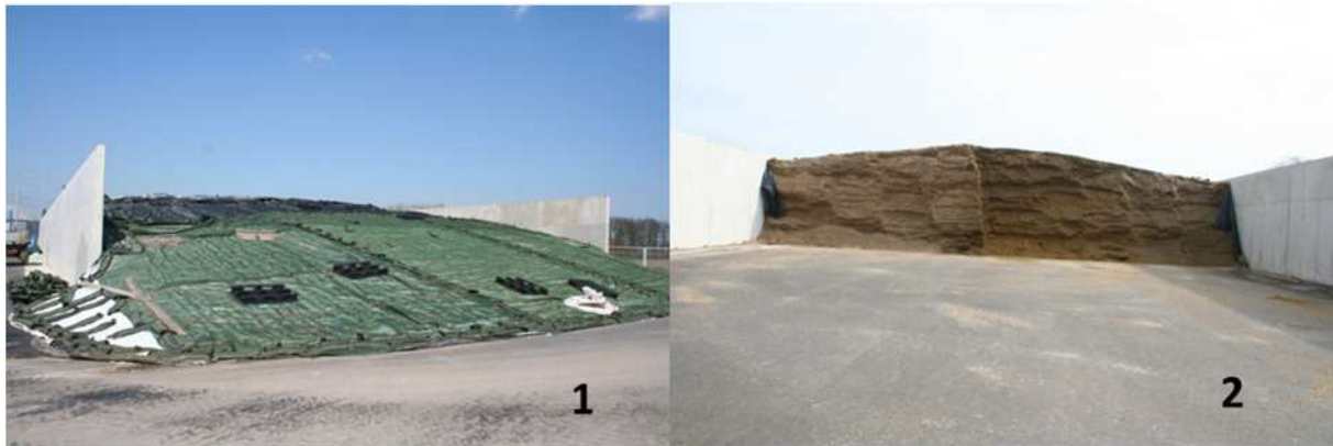
Abb. 8.5: Flachsilos für Maissilage: 1 = Flachsilo mit Folie abgedeckt, 2 = Silo im Vortrieb (Bildquellen: Autor)
