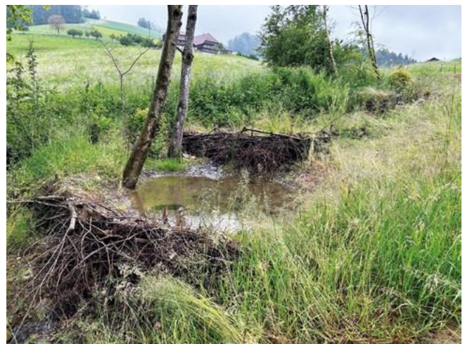
Bild: 7 Beaver Dam Analogs in Funktion, Projekt Uechtgraben. In steilem Gelände sind BDA-Kaskaden essentiell, um Abflüsse zu bremsen und die Umgebung nachhaltig zu rehydrieren. Es resultieren eher kleine, dafür aber häufige Einstaubereiche, welche die Sohlenerosion und die Absenkung des lokalen Grundwasserniveaus verhindern und gleichzeitig ökologisch wertvolle wechselfeuchte Zonen schaffen. (Foto N. Werdenberg).
