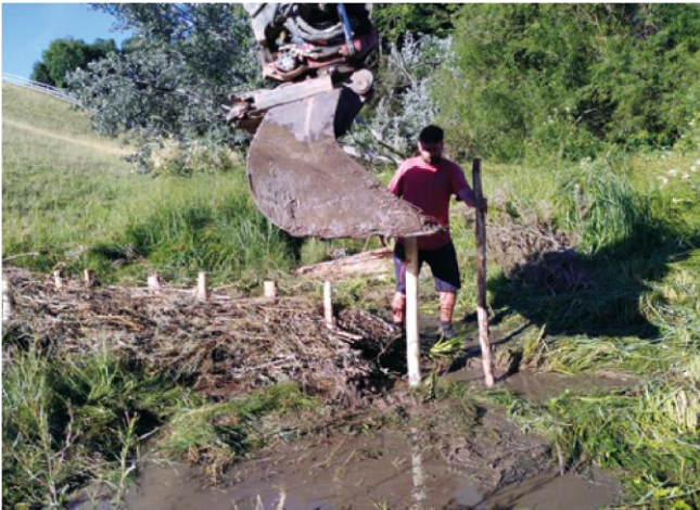
Bild: 1 Bau von Beaver Dam Analogs mit maschineller Unterstützung bei Aushub, Pfählen und Hinterfüllen. Das Flechten bleibt ohnehin Handarbeit. (Foto N. Werdenberg).
