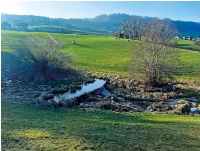
Bild: 3 Beaver Dam Analog in Funktion, Projekt Schlossbach. Nahaufnahme mit Einstau- und Zwischenbereich. Die Einstaubereiche drosseln den Abfluss, puffern den Wasserhaushalt und schaffen ökologisch wertvolle wechselfeuchte Zonen. In den Zwischenbereichen etablieren sich wertvolle Fließstrecken mit dynamischen Nebengerinnen (Foto: S. Minnig).
