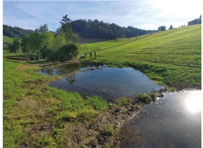
Bild: 6 Beaver Dam Analogs in Funktion, Projekt Uechtgraben. Die hier umgesetzte BDA-Kaskade weist kaum Zwischenbereiche auf. (Foto: N. Werdenberg).
