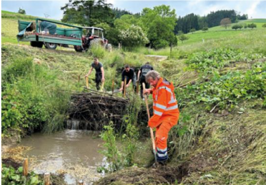
Bild: 8 Bau von Beaver Dam Analogs händisch. (Foto K. Falk).
