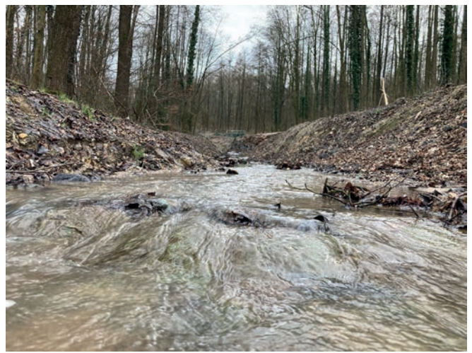
Abbildung 14: neu profiliertes Bachbett mit eingebauten Sohlgleiten (Tiefbauamt Bundesstadt Bonn)
