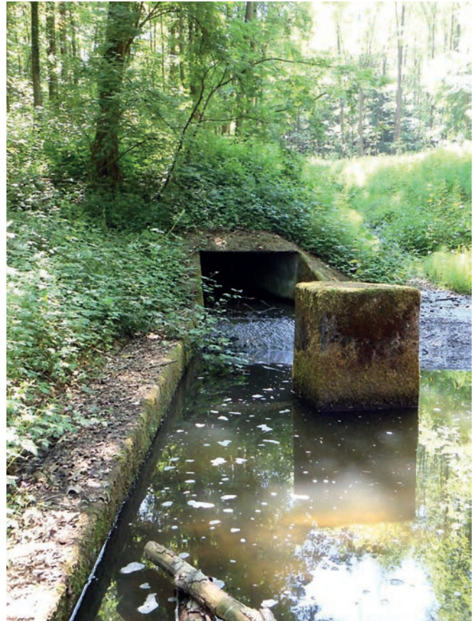
Abbildung 13: altes Bachbett mit Rasengittersteinen und Betonelementen (Tiefbauamt Bundesstadt Bonn)
