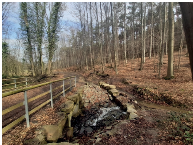
Abbildung 3: Profilierung zur eigendynamischen Entwicklung des oberen Bachlaufs im Waldbereich (Tiefbauamt Bundesstadt Bonn)
