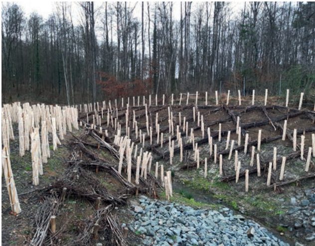
Abbildung 17: Geotextil, Faschinenrauten und Baumpflanzungen entlang von Holtorfer Bach und Holzlarer See (Tiefbauamt Bundesstadt Bonn)
