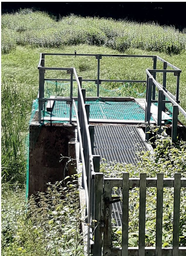
Abbildung 18: Sicherungsnetz am alten Mönchbauwerk für die Gebirgsstelze (Tiefbauamt Bundesstadt Bonn)
