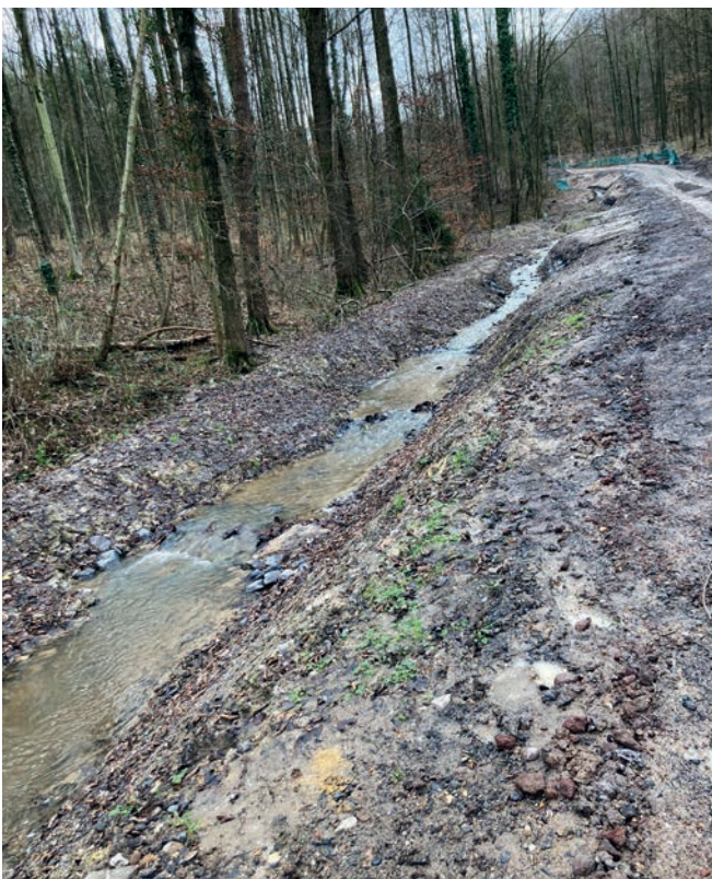
Abbildung 14: neu profiliertes Bachbett mit eingebauten Sohlgleiten (Tiefbauamt Bundesstadt Bonn)
