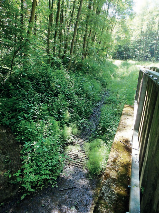
Abbildung 13: altes Bachbett mit Rasengittersteinen und Betonelementen (Tiefbauamt Bundesstadt Bonn)
