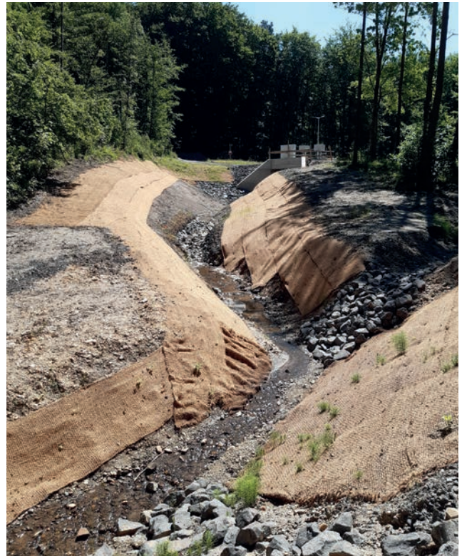
Abbildung 17: Geotextil, Faschinenrauten und Baumpflanzungen entlang von Holtorfer Bach und Holzlarer See (Tiefbauamt Bundesstadt Bonn)
