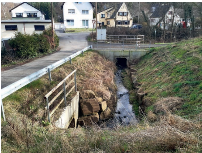
Abbildung 16: Anschluss des neuen Bachbetts an den alten Verlauf, Leitplanke dient für Anliegerstraße als Absturzsicherung (Tiefbauamt Bundesstadt Bonn)
