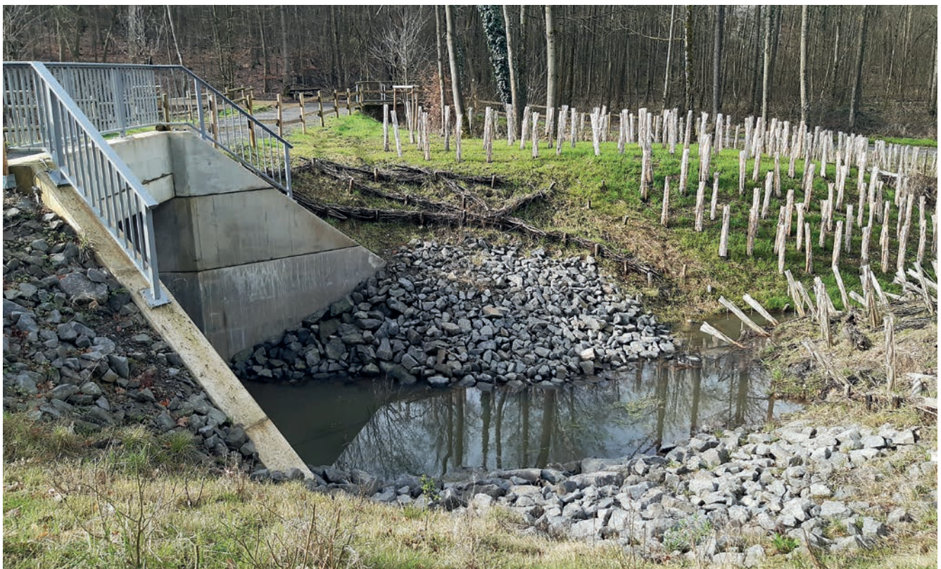
Abbildung 12: Sicherung der Hänge mit Wasserbausteinen (Tiefbauamt Bundesstadt Bonn)
