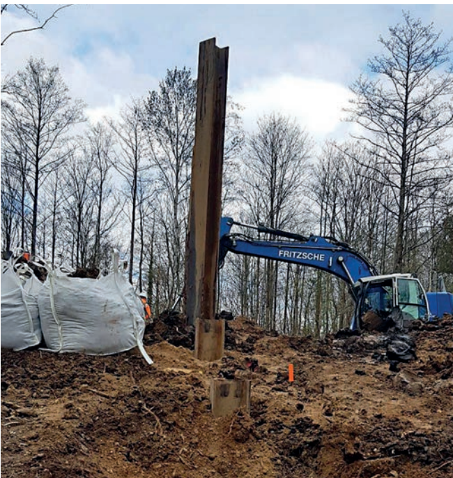
Abbildung 21: 14 m lange HEB-Träger zur Gründung des Drossel- und Durchlassbauwerks (Tiefbauamt Bundesstadt Bonn)
