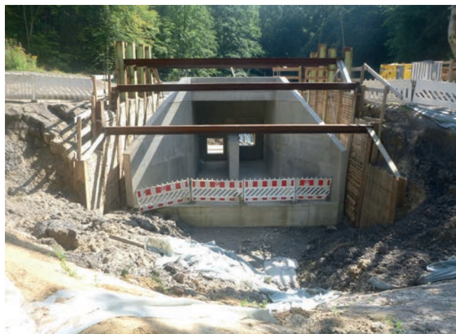
Abbildung 9: neues Durchlass- und Drosselbauwerk während der Bauphase (Tiefbauamt Bundesstadt Bonn)
