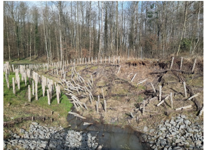
Abbildung 22: Während der Bauphase kam es aufgrund der ungünstigen Bodenverhältnisse immer wieder zu Rutschungen an Hängen (Tiefbauamt Bundesstadt Bonn)
