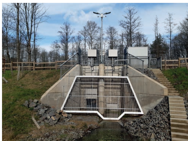
Abbildung 10: fertiges Durchlass- und Drosselbauwerk mit Rechen und M+E-Technik vom Rückhaltebecken aus gesehen (Tiefbauamt Bundesstadt Bonn)
