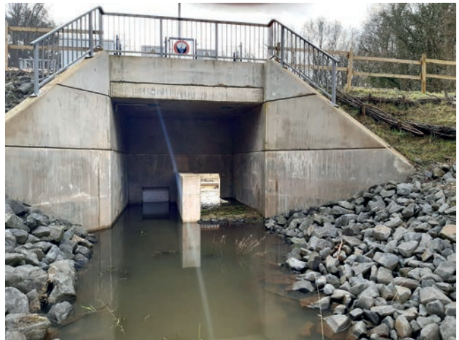
Abbildung 11: Auslass des Durchlass- und Drosselbauwerks mit aquatischer (links) und terrestrischer (rechts) (Hochwasser-)Rinne (Tiefbauamt Bundesstadt Bonn)
