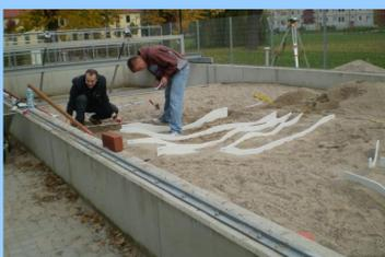
Bild 10: Einbau der Querprofile
