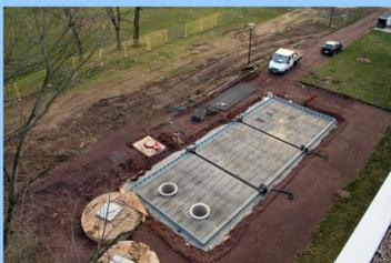
Bild 5: Gießen der Bodenplatte
