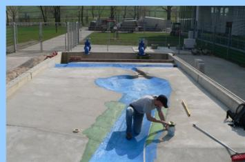
Bild 13: Kennzeichnung des Flussschlauches
