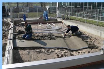
Bild 11: Herstellung der Geländeoberfläche mittels Estrich
